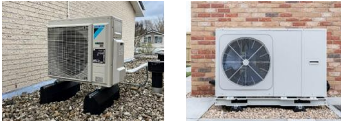
Figuur 19 – Voorbeelden van een buitenunit van een warmtepomp
