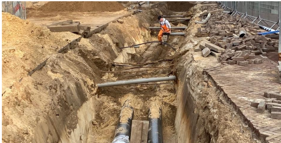
Figuur 31 – Werkzaamheden voor het realiseren van een MT-transportleiding tussen de bestaande infrastructuur
