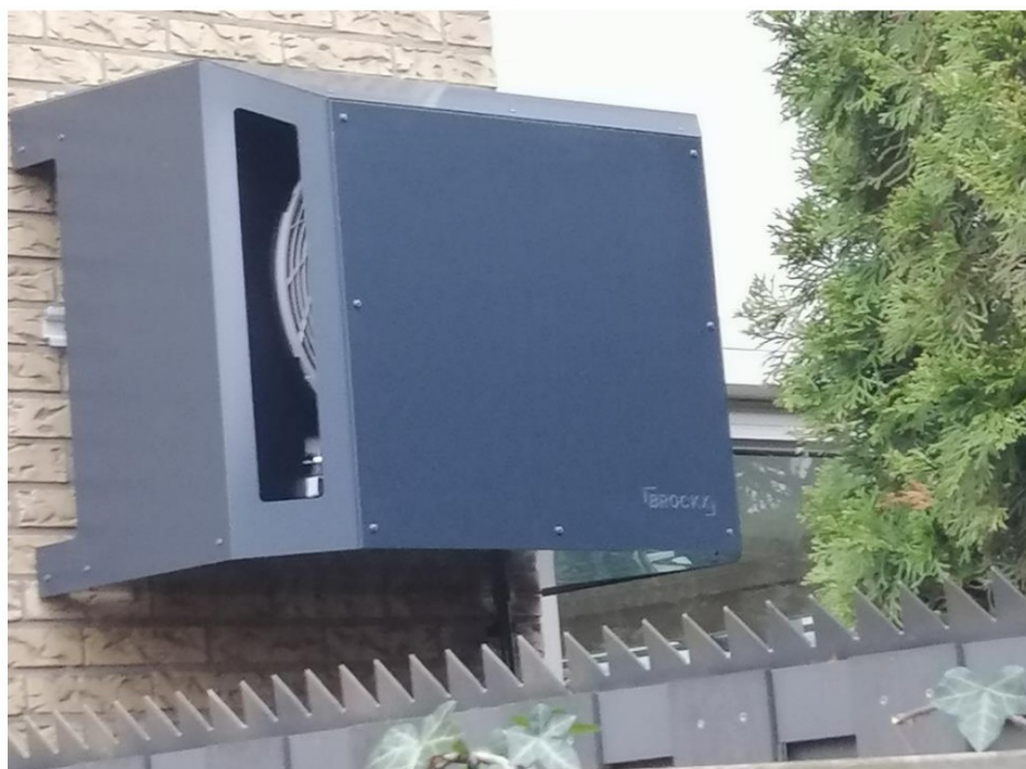
Foto na plaatsen omkasting
