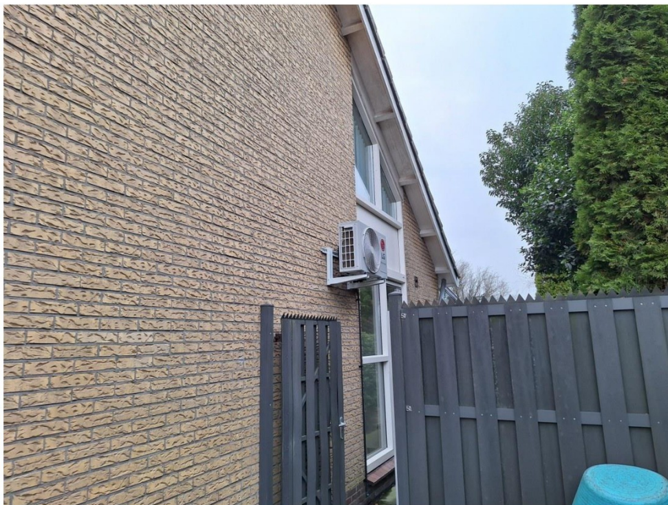
Foto gemaakt vóór het plaatsen van de omkasting (merk Brockx)
