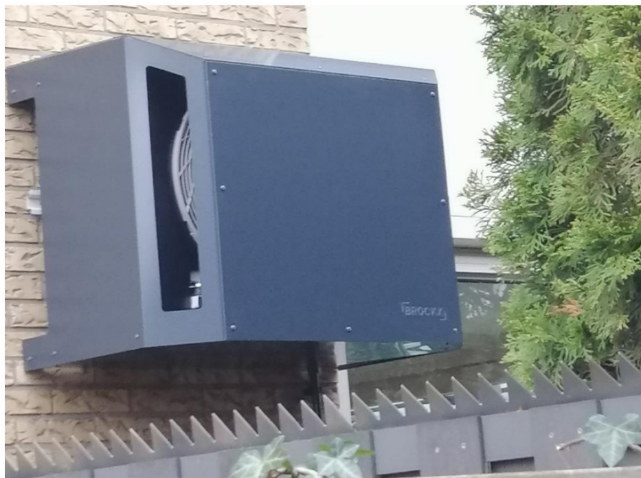
Foto na plaatsen omkasting
