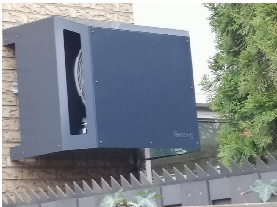
Foto na plaatsen omkasting
